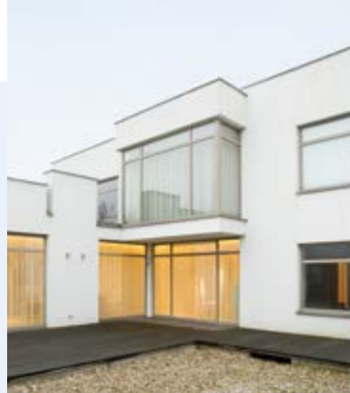
Εφαρμογή Silatex® Reflect στις εξωτερικές κάθετες επιφάνειες
