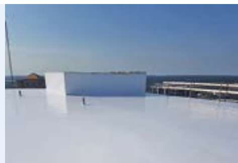
Εφαρμογή Neorooft ® σε δώμα με λιμνάζοντα νερά
